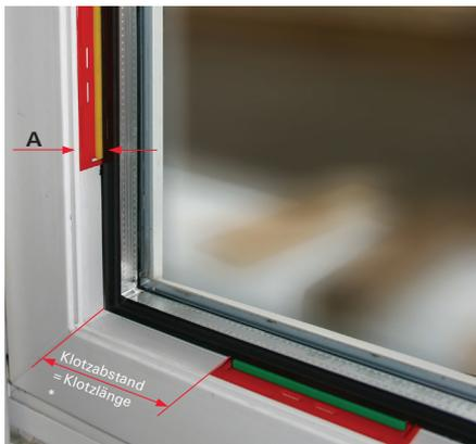
**Beispiel für eine ordnungsgemäße Verklotzung** mit 5 mm Klotzstärke und 100 mm Klotzlänge, unter Berücksichtigung der richtigen Anordnung und der korrekten Abstände.
