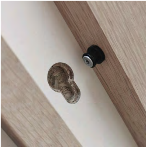
Keiltasche zur Aufnahme von Massivholzlamellen
