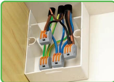
Verbindung vorverdrahteter Fertigelemente, wie z. B. in Wohnmobilen
